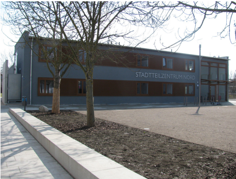
Das neue Stadtteilzentrum Nord
