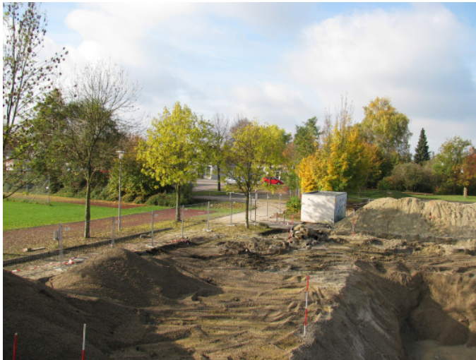
Baubeginn des Stadtteilzentrum Nord
