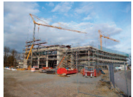
Rohbau des Technologiezentrums
