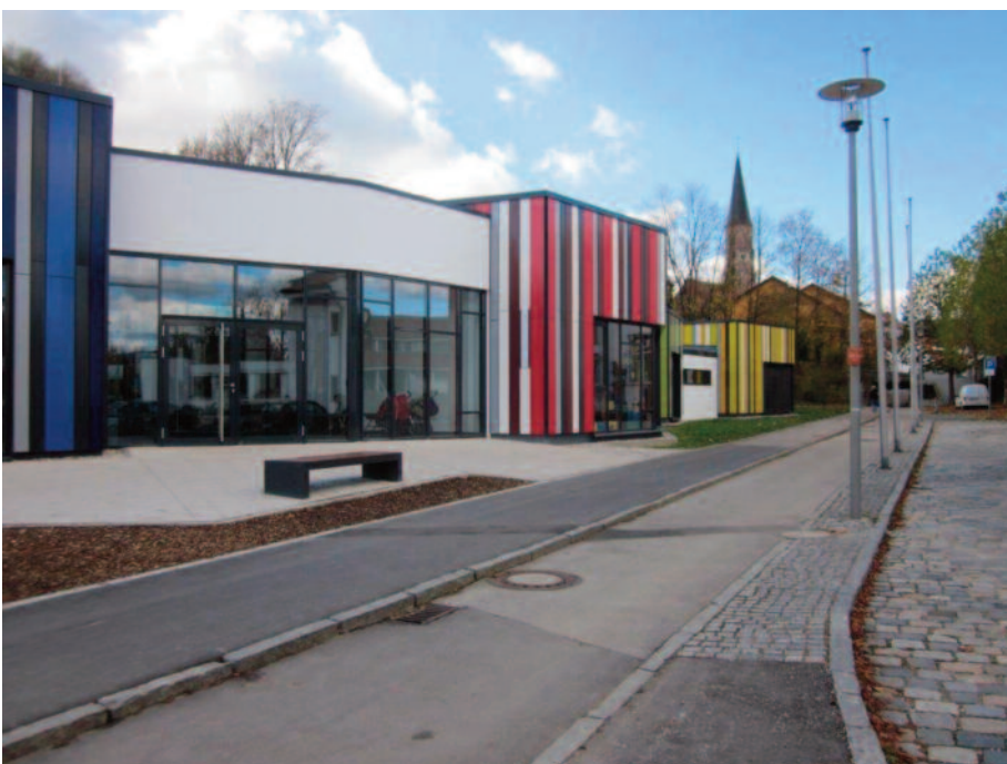
Der Kindergarten St. Johannes wurde neu gebaut.
